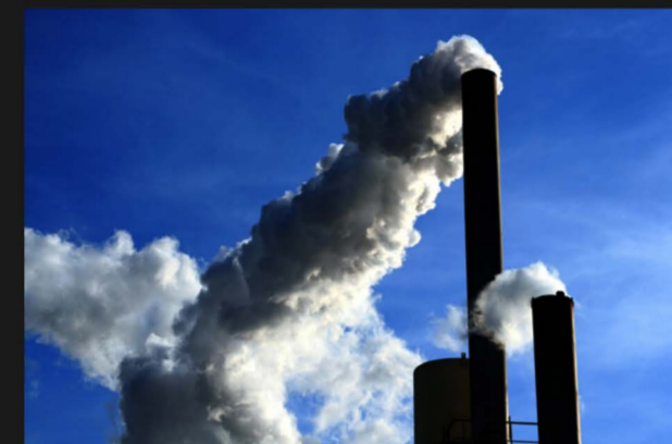
Production d'énergie électrique
